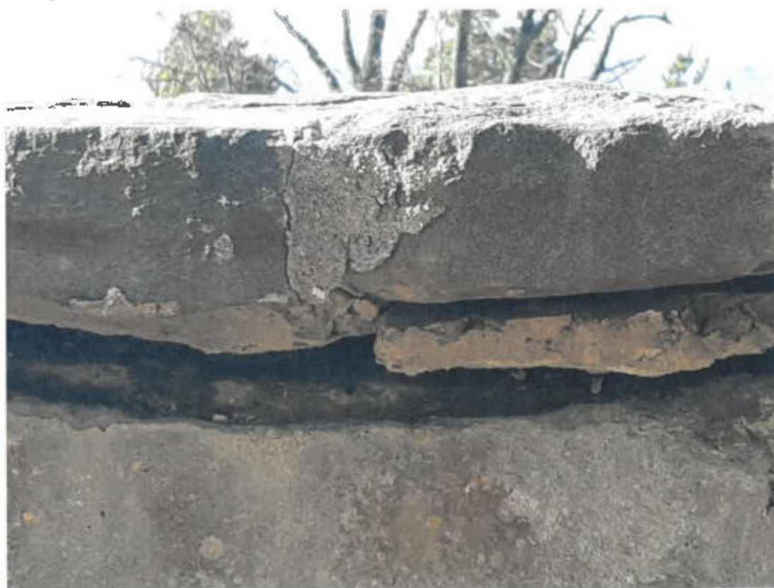
Chýbajúce škárovanie hrádobného múru spôsobené neprazdnivými poveternostnými vplyvmi – hnaným dažďom a mrazmi
