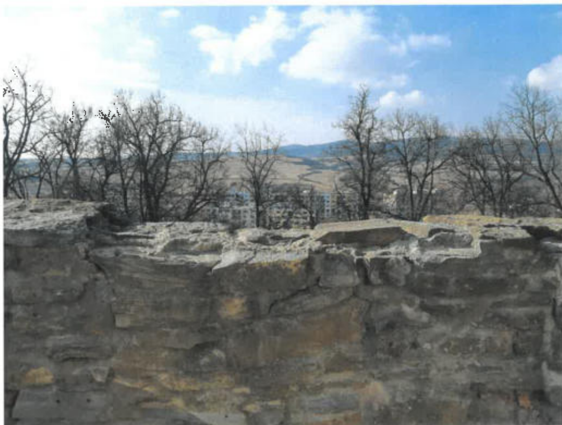
Chýbajúce škárovanie hrádobného múru spôsobené neprazdnivými poveternostnými vplyvmi – hnaným dažďom a mrazmi
