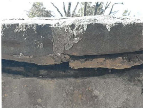
Chýbajúce škárovanie hradobného múru spôsobené nepriaznivými poveternostnými vplyvmi – hnaným dažďom a mrazmi
