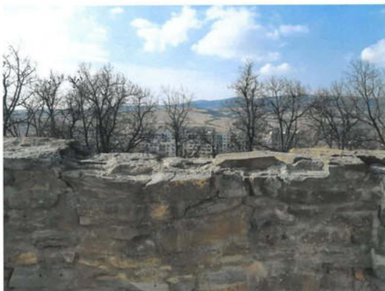
Chýbajúce škárovanie hradobného múru spôsobené nepriaznivými poveternostnými vplyvmi – hnaným dažďom a mrazmi
